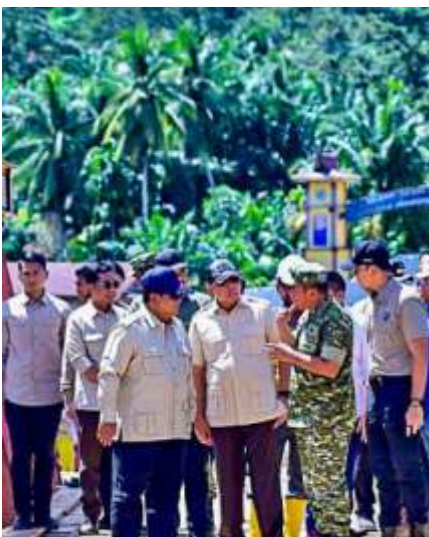
Presiden Prabowo Subianto ketika meninjau langsung pembangunan Jembatan Bailey di Sungai Garoga, Kecamatan Batang Toru, Kabupaten Tapanuli Selatan, pada Rabu (31/12/2025). (dok.BPMI Setpres)
