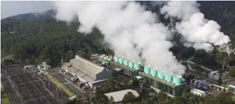
Foto udara Pembangkit Listrik Tenaga Panas bumi (PLTP) di Pertamina Geothermal Energy (PGE) Area Kamojang, Kabupaten Bandung, Jawa Barat, Senin (15/9/2025). (Ant)
