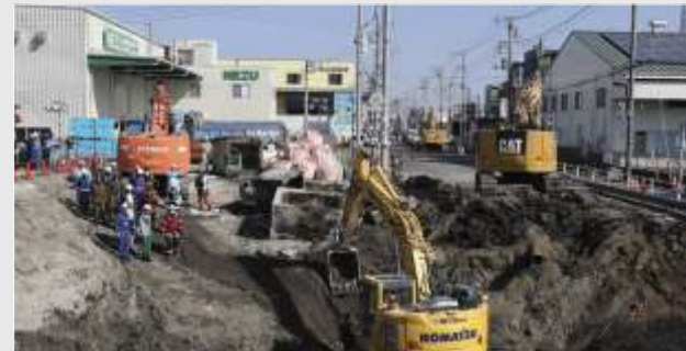
Tim SAR menggunakan ekskavator untuk mencari sopir truk yang terperosok lubang jalan atau sinkhole di Kota Yashio, Prefektur Saitama, Jepang, Sabtu (1/2/2025). Pengemudi itu dan truk yang dikendarainya terperosok masuk lubang pada Selasa (28/1/2025). (AFP)
